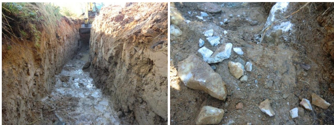
Dikesgrävning och provtagning vid Silvergruvan hösten 2012.
